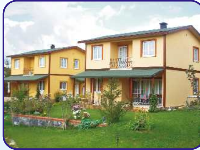
Ada İnşaat - İSTANBUL
