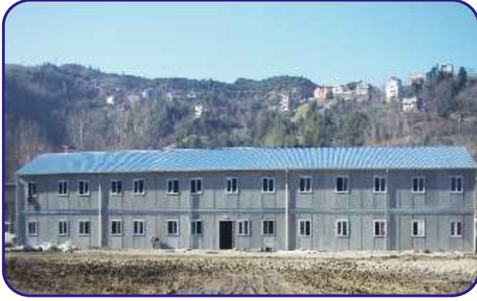
Prefabrik Yatakhane Yapıları / Prefabricated Dormitory Construction
